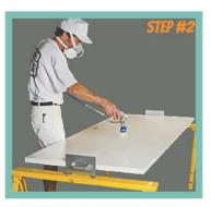
LAY THE DOORS ON SAW-HORSES, SPRAY THE SIDE OF DOOR THAT IS FACING UPWARD & THE EDGE OF THE DOOR THAT IS CLOSEST,
